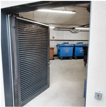
Standplatz im Gebäude, ebenerdig, von außen direkt zugänglich und gut belüftet
